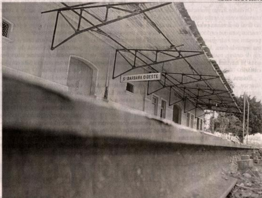
A estação nos dias de hoje: prazo para conclusão das obras, anunciadas ontem, é de três anos
